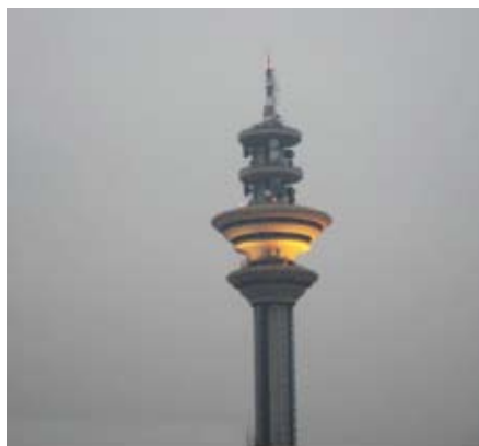
Rozzano • La Torre Telecom
